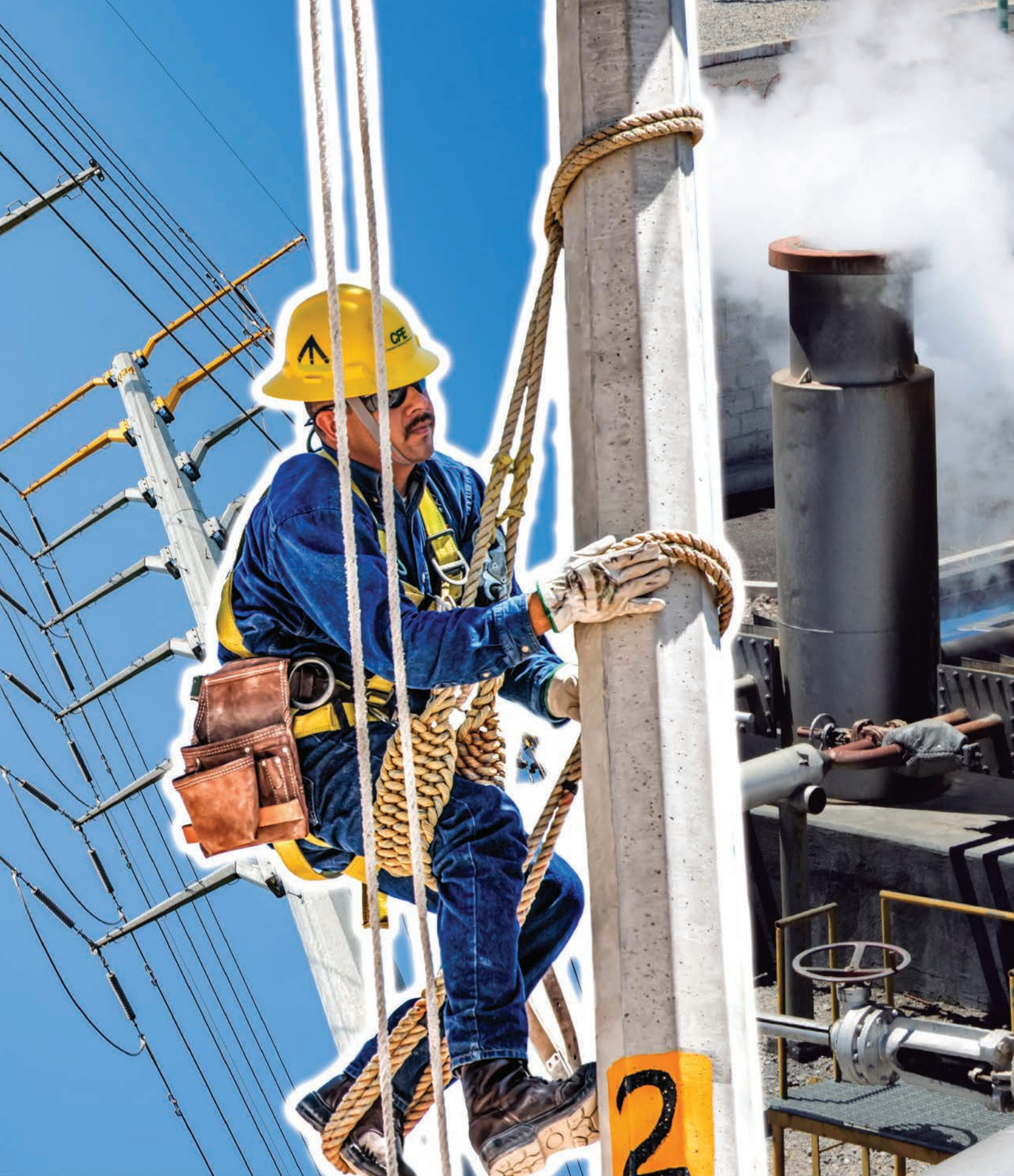
Torre de transmisión, Monterrey. Central geotérmica, Chignautla, Puebla. Comisión Federal de Electricidad.
