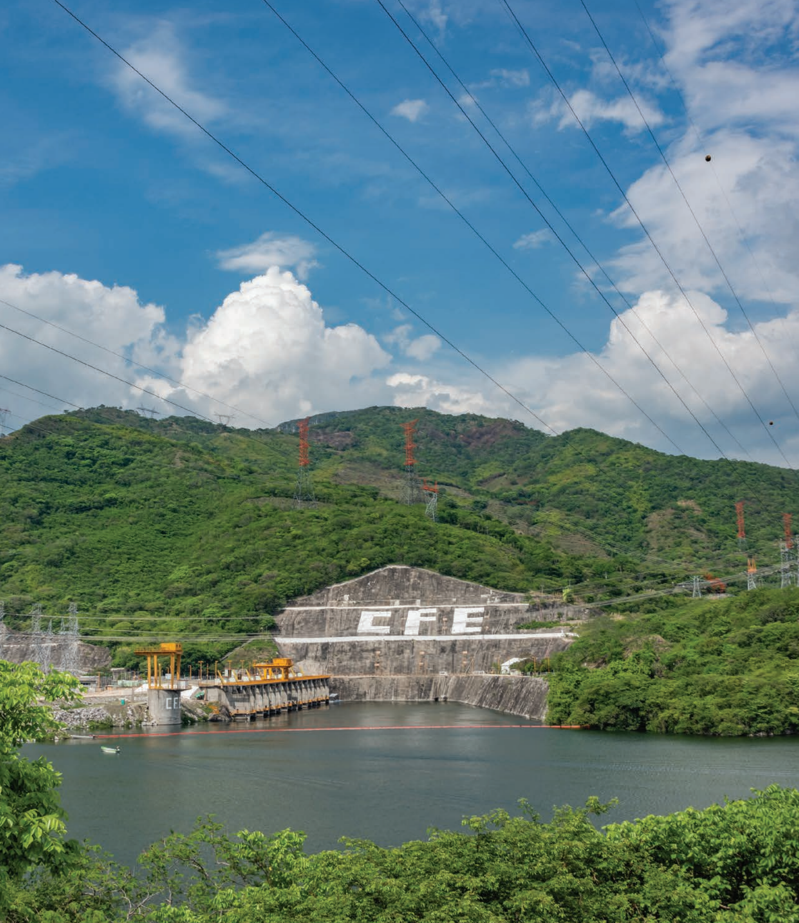
Central hidroeléctrica, Chicoasén, Chiapas. Comisión Federal de Electricidad.
